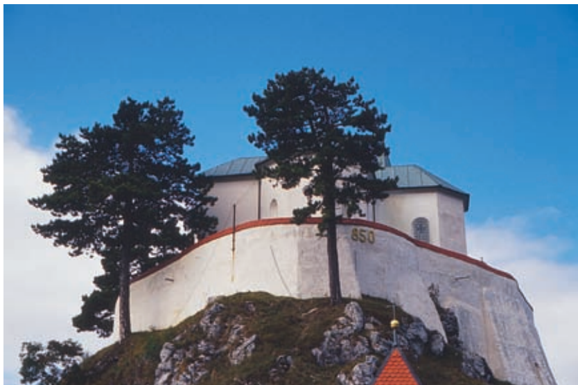
Obzidje drži umetno zravnano ovršje Zasavske svete gore, na katerem sta svetišče in božja njiva.
